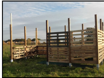
Un nouvel abri en construction
